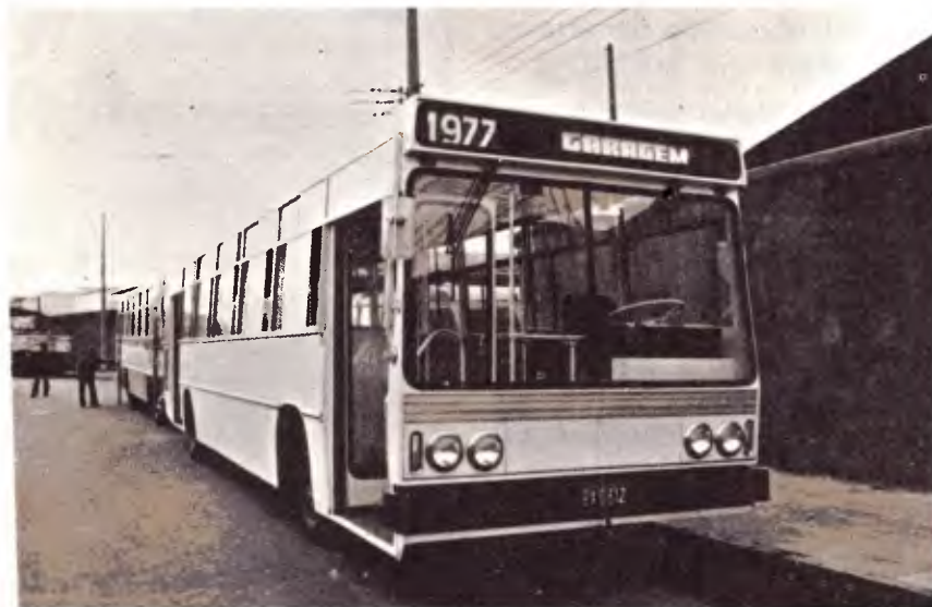
O parabrisa foi rebaixado para aumentar a visibilidade do motorista.
