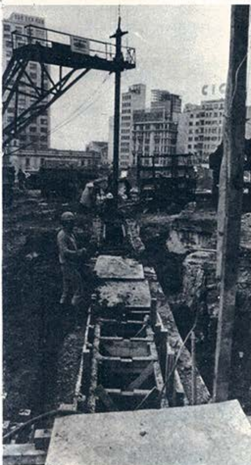
A parede-guia mantém a diretriz da vala e evita deslizamentos na borda.
