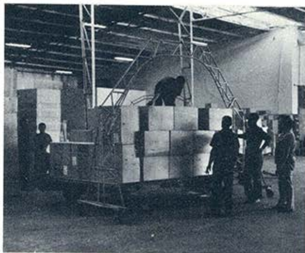
Para se chegar ao formato da cabina, aplicam-se gabaritos sobre o carrinho ou a pista onde se faz a montagem do estrado.
