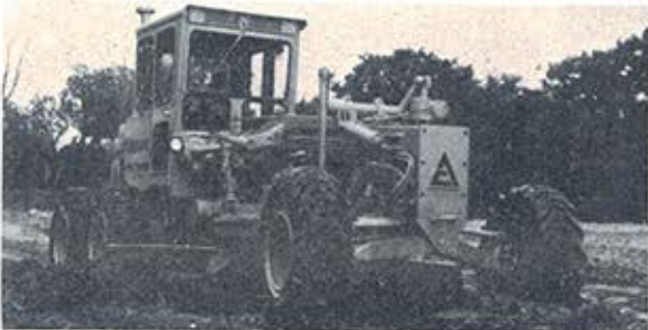
A motoniveladora 200C tem 14 t de peso e 160 HP de potência.
