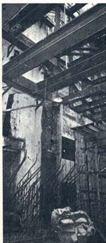
As estroscas absorvem os esforços eventuais.
