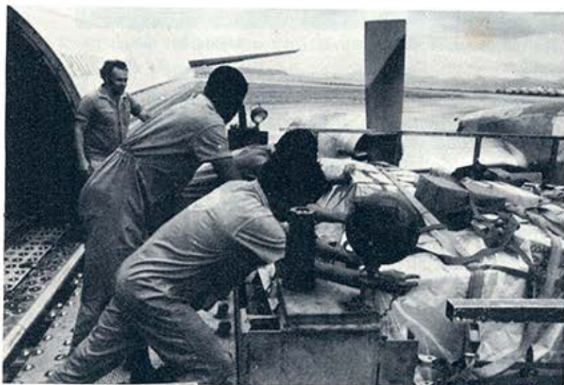
Depois de ajustar o elevador à altura do aparelho, basta colocar ou retirar o pallet da mesa de elevação do monta-carga.
