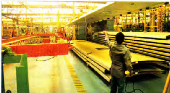
A adoção de processos avançados na fábrica da Caio reduz de 146 para 52 as etapas de montagem
