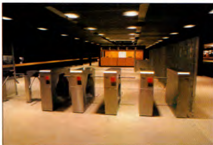
Moderno sistema de catracas eletrônicas acelera o fluxo de usuários nos terminais
