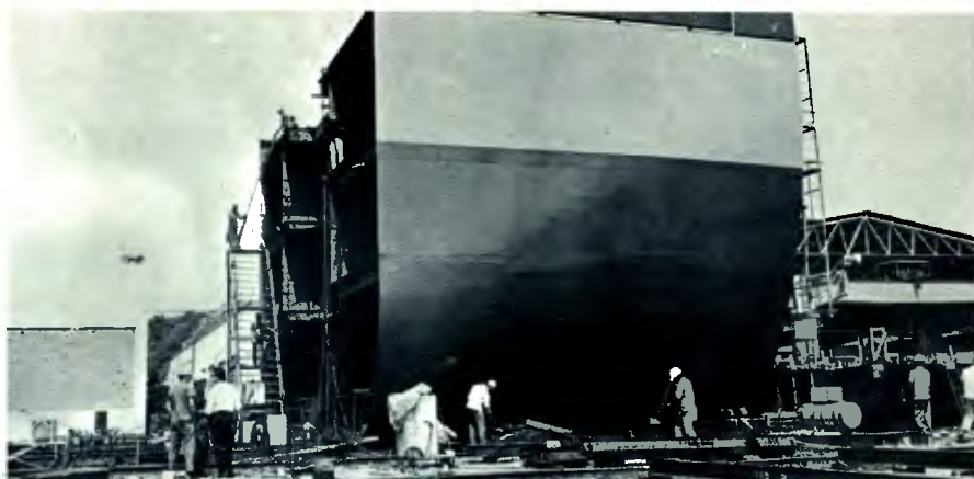
Arrasto também é eficiente na movimentação de blocos em construção de navios.
