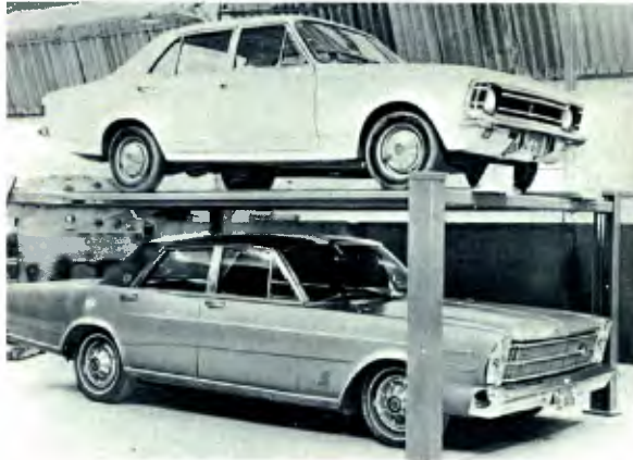
Elevador permite melhor aproveitamento de garagens.
