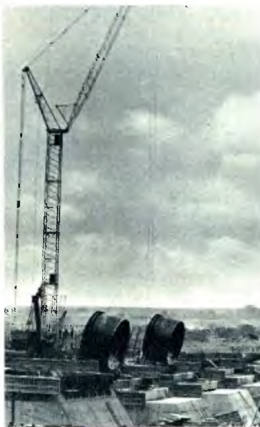
Um guindaste ajuda na concretagem.
