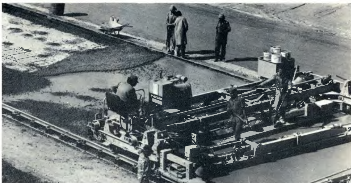
Seiscentos metros de pista de sete metros, por dia de dez horas. Este é um dos trunfos do cimento portland.
