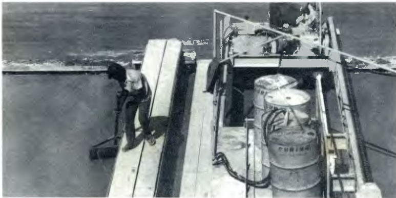
A última máquina asperge o "curing compound" que impede a evaporação.
