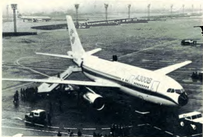
Airbus A 300 B: bimotor subsônico de grande fuselagem, pode transportar até trezentos passageiros em percursos de 300 a 3 000 km, à velocidade de 900 km/hora.
