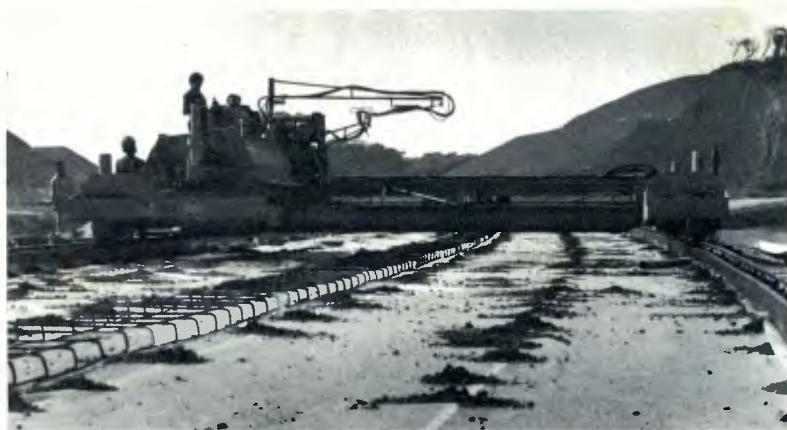
A primeira das máquinas recebe e espalha o concreto sobre o lençol plástico.
