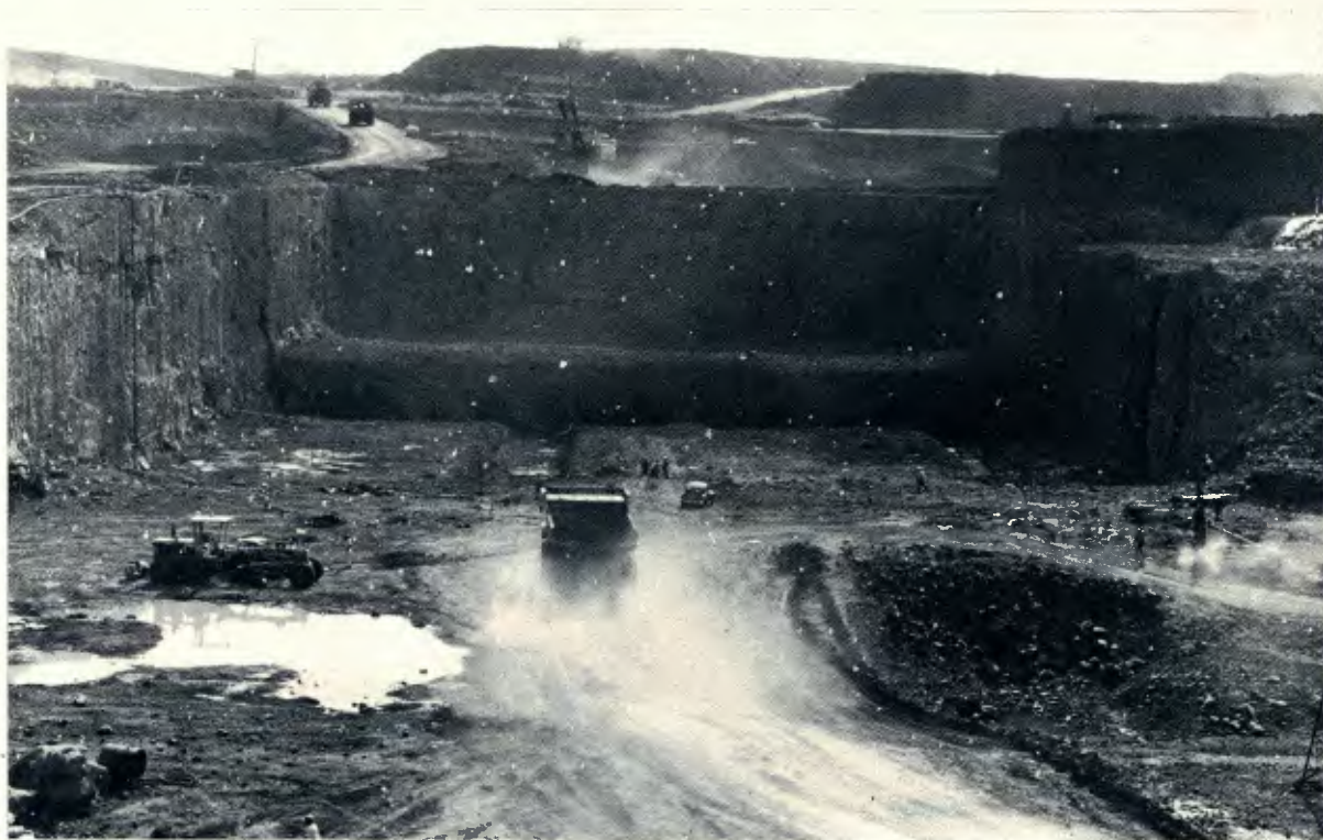
Em maio, as escavações em rocha atingiram o pico: 360 000 m 3 . A técnica do pré-fissuramento assegurou o recorde.
