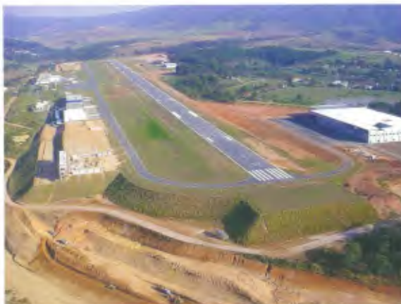
Em Jundiaí as obras incluem pavimentação do sistema viário
