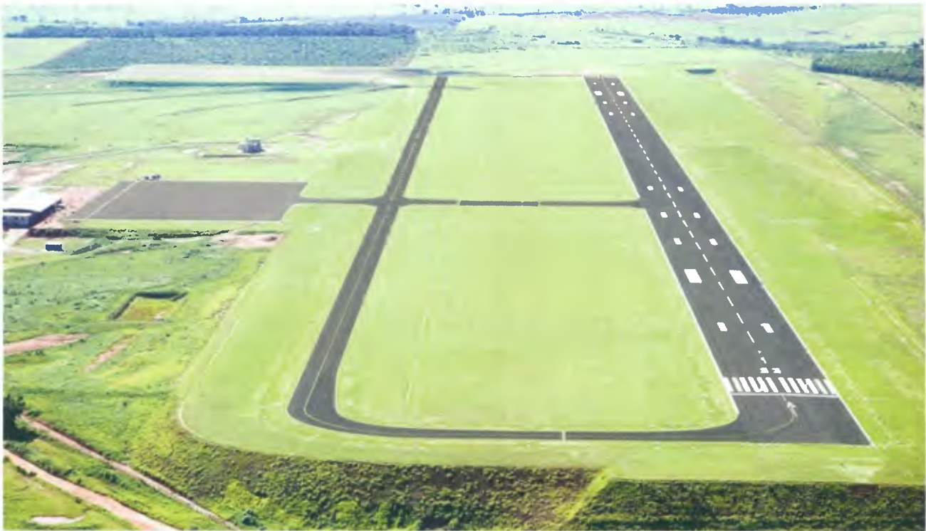
No aeroporto de Bauru/Frealva foi instalado e equipado de auxílio à navegação aérea neste ano
