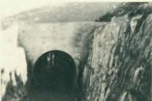
A seção de vazão da galeria tem quase 200 m<sup>2</sup>
