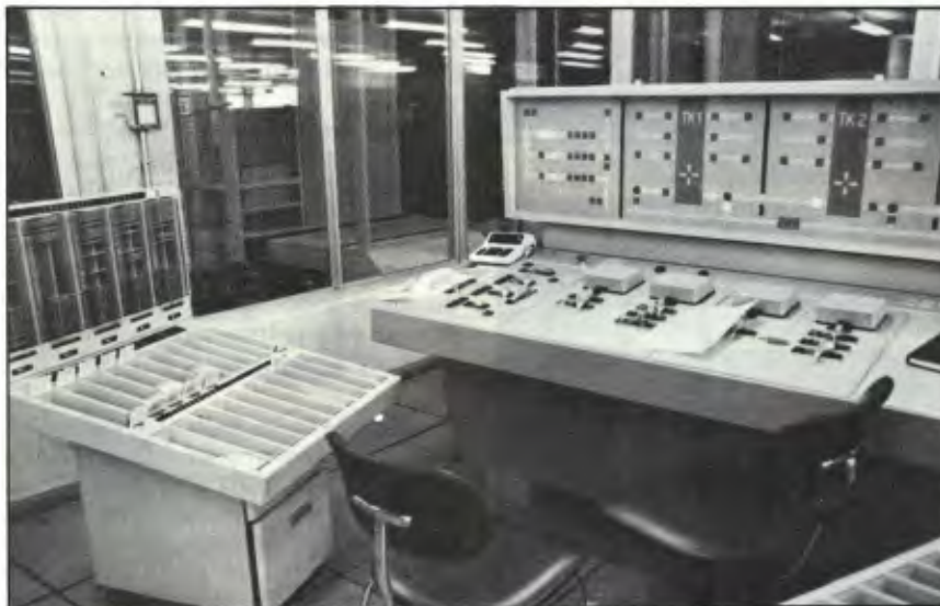
Os controles dão idéia exata do movimento e de qualquer falha do sistema, aumentando a margem de segurança. À cima, o Rapistan cuidando dos transportadores e a controladora de depósito.
