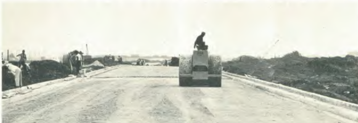
Base: de acôrdo com a TB-17, uma camada destinada a resistir e distribuir esforços recebidos.
