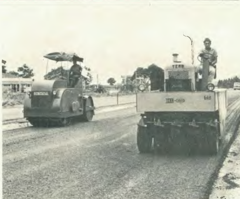
PTB-51: inclui equipamentos de terraplenagem e rolos de compactação.
