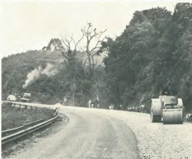
Máquinas de compactação sem vibração: energia fornecida sob pressão.
