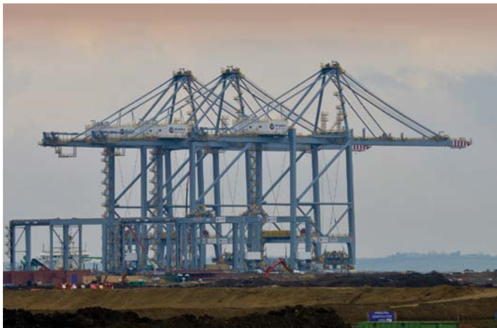
No porto, 24 guindastes com 138 m de altura movimentarão os contêineres ao longo do cais
