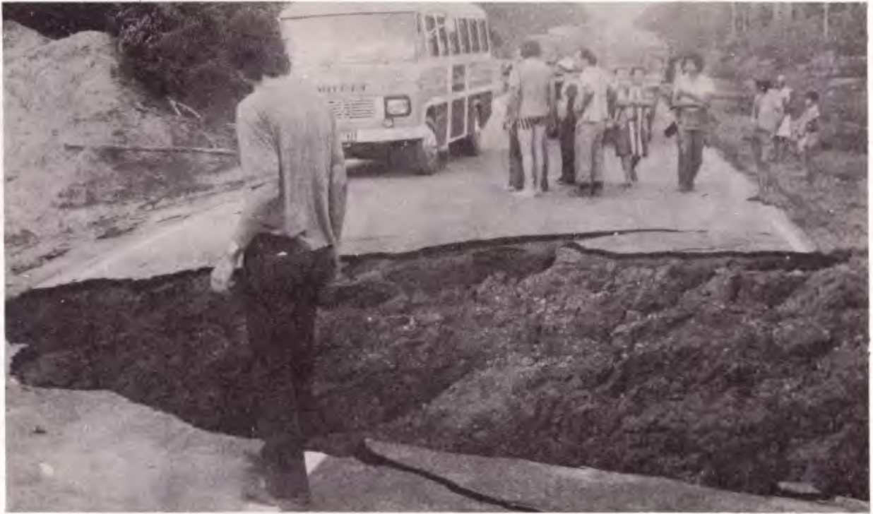
O resultado do estouro de um boeiro: uma cratera, dividindo a pista em duas partes.
