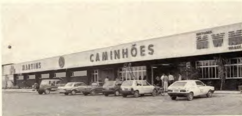
A sede da Martins Caminhões em Porto Velho: ampliada em 1 750 m 2
