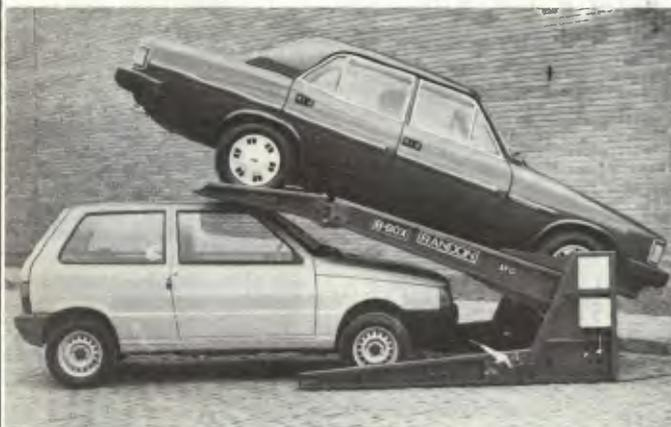
A Randon está lançando o B-Box, ou dupla garagem, um elevador hidráulico cuja principal função é duplicar a capacidade de estacionamento de garagens. Pode ser usada, também, para acomodar rebocues, motos e barcos, mantendo o espaço original dos estacionamentos.
