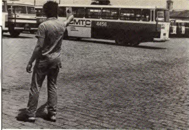
Utilizada corretamente, a escala Ringelmann mede a densidade da emissão da fumaça
