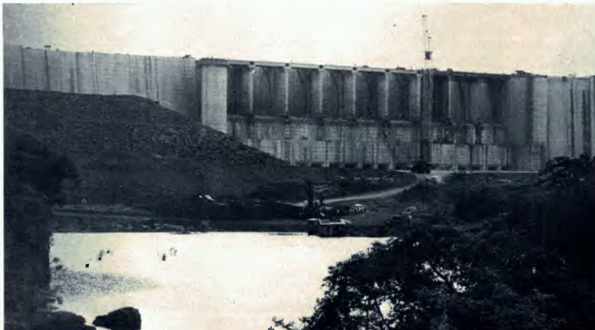
Marimbondo quebrou o recorde de argila compactada: 800 000 m 3 por mês.
