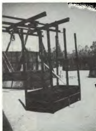
Montagem: primeira etapa
