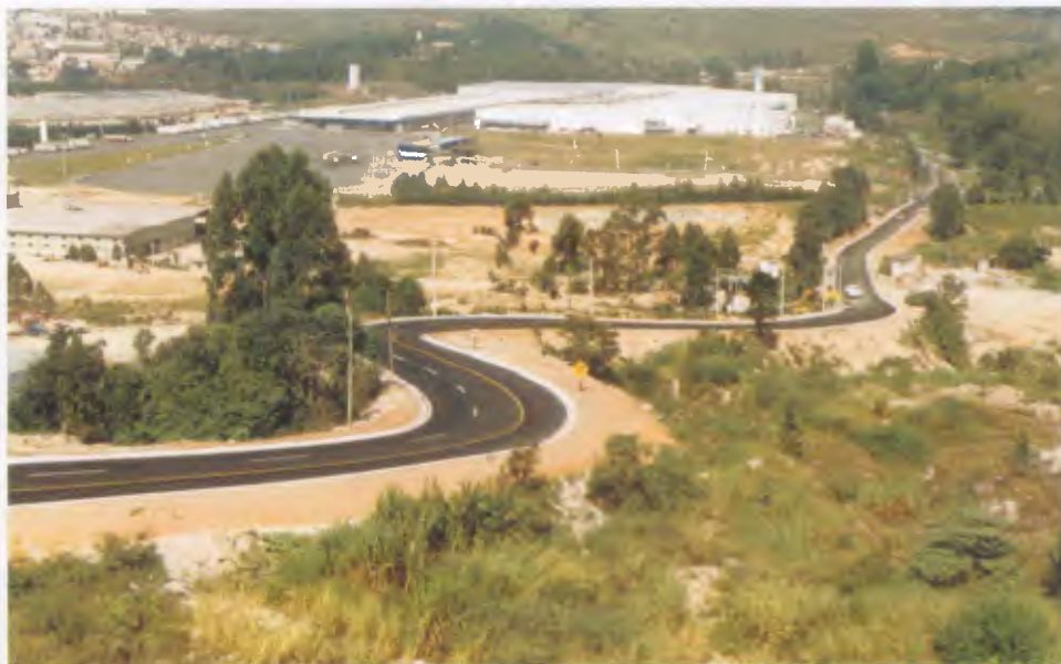
Corredor Tecnológico, de 2,3 km, tem 5 tipos de revestimento asfáltico
