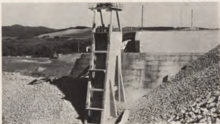
Raros são os dias de sol. Na foto, vertedouro e comporta da barragem.
