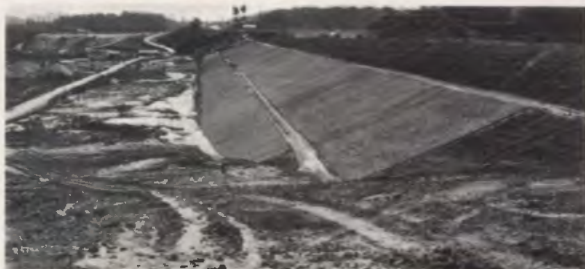
Barragem: vista do maciço compactado. Com chuvas o acesso é impossível.
