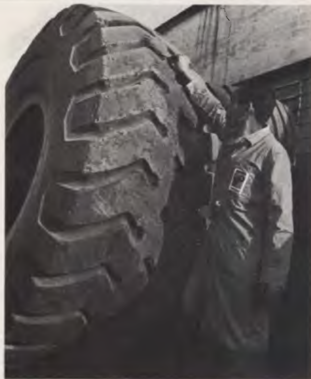
Vacu-lug permite modificação nos desenhos dos pneus.
