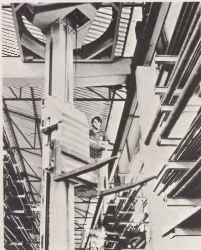
O equipamento gira 360° contínuos. O garfo sobe e desce com precisão.
