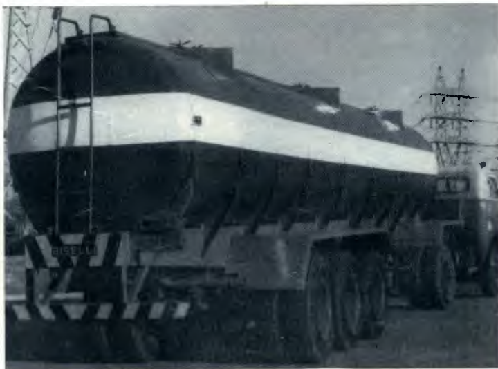
A fibra de vidro e o alumínio começam a ser utilizados nos tanques.
