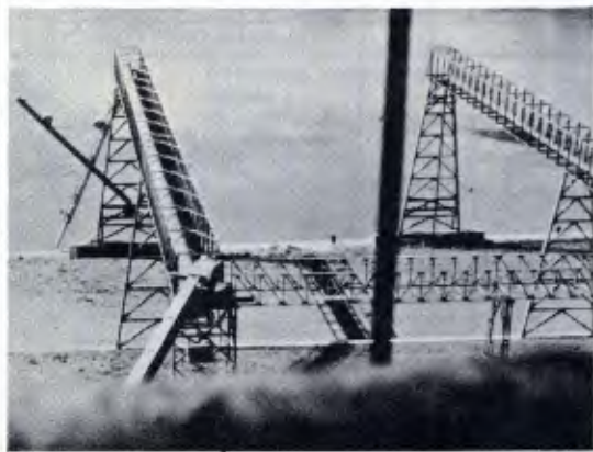
A transferência da carga do caminhão ao navio exige o trabalho de poucos homens. Deixada na tremonha, ela passa por várias correias, pelo elevador, é pesada e, finalmente, levada ao tubo telescópico, já dentro do navio.
