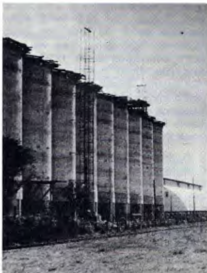
O silo já está em fase final de construção.
