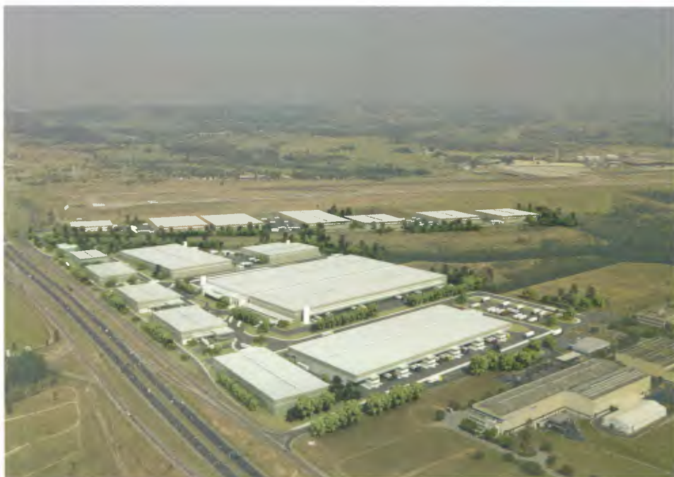
Ilustração do centro empresarial e de logística a ser construído na divisa com Viracopos
