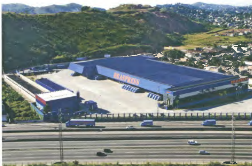
Nova unidade da Braspress em São João do Meriti possui 14 docas de carga e descarga
