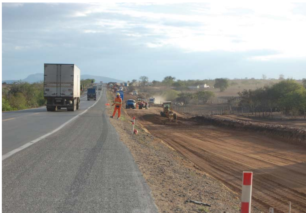
A ViaBahia está investindo R$ 280 milhões nas obras de duplicação da rodovia
