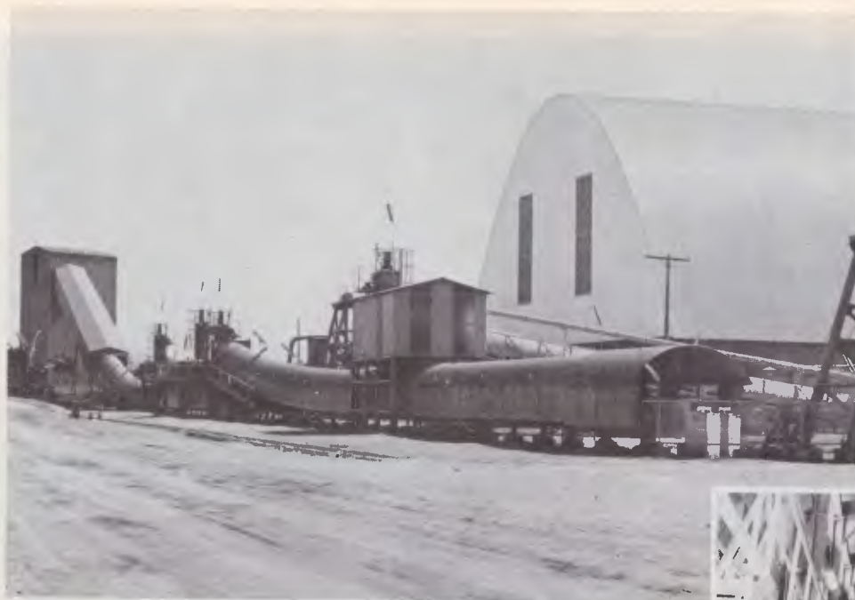
A correia coberta construída pela Cia. Vale, transporta o farelo de soja do silo até o navio, a uma velocidade de 1 500 t/hora
