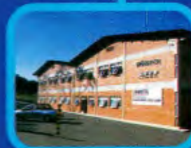
UNIDADE DE FUNDIÇÃO DE NÃO-FERROSOS
