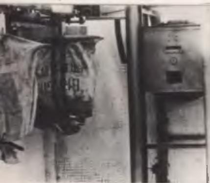
Na parte final da linha, uma segunda corrente transfere o carrinho para um elevador, que, por sua vez, eleva os malotes até o quarto andar (23 m de altura). Lá, há uma nova transferência. Os carrinhos passam para um novo sistema de trilhos, desta vez de 41 m de comprimento, acionado por motor de 0,75 cv.
