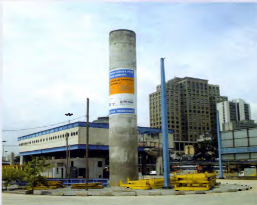
Terminal em construção do eixo Dom Pedro-Sacomã, com movimentação prevista de 40 mil passageiros/dia
