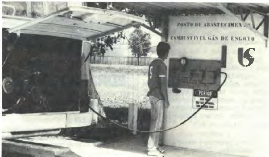
Abastecimento de metano, por enquanto é feito na estação Leopoldina da Sabesp.
