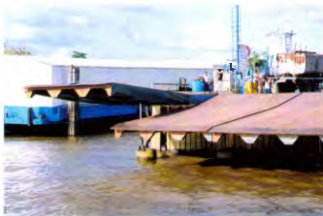
Plataformas hidráulicas da Bertolini em Belém: altura ajustada conforme o nível do rio
