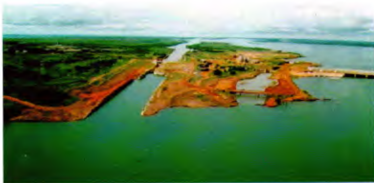
Construção de eclusa permite a integração dos rios
