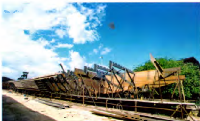
Barco da Bertolini em construção tem estrutura reforçada contra obstáculos no rio
