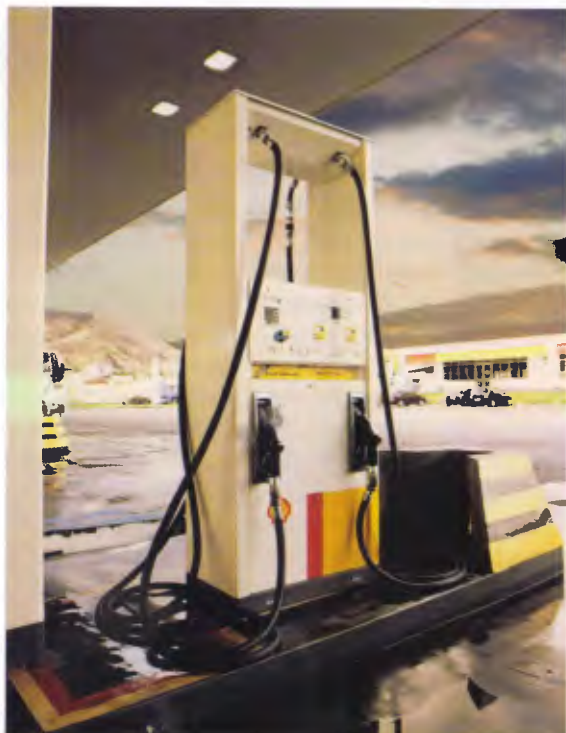
Shell Monitor instalado em 40% dos postos
