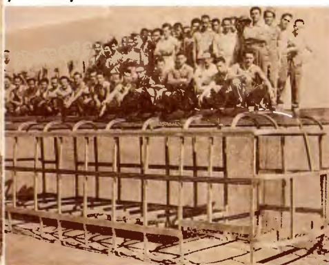
Leveza e alta resistência do alumínio. Nas fotos os cajados do teto são postos a prova
