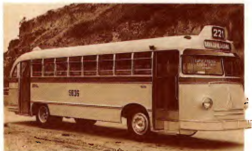
Monobloco Magirus-Ciferal, com captador para arrefecimento do motor traseiro
