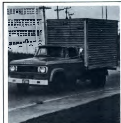
Motor Perkins de 90 hp e curto entre-eixos fazem do P-400 uma boa opção para a cidade.
