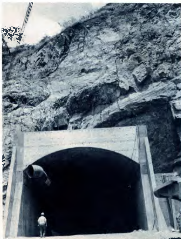
Uma das galerias para escoar as escavações da caverna.
