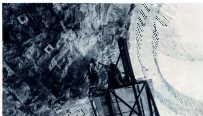
Só na abóbada será necessário colocar 3 200 chumbadores.
