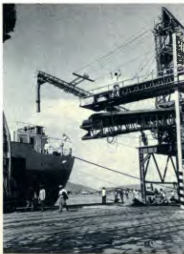
Essencial melhorar as instalações.
