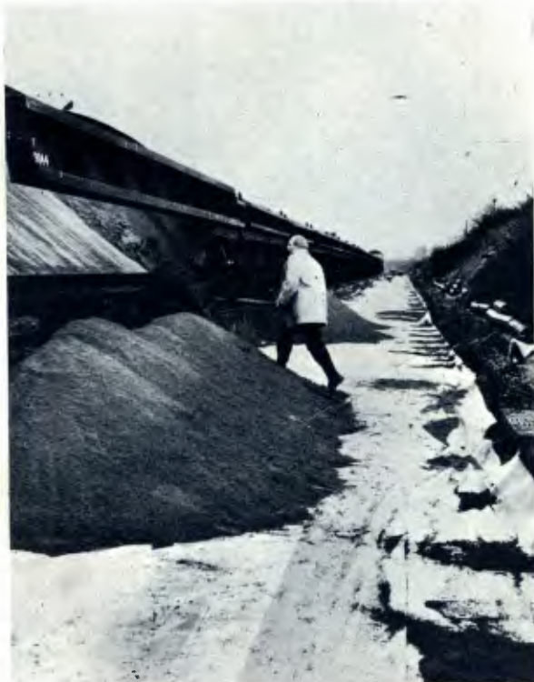
Colocação do saibro sobre forros plásticos.
