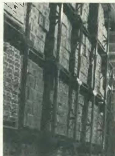
O sistema é dotado de suporte nas colunas, para apoio dos pallets.
