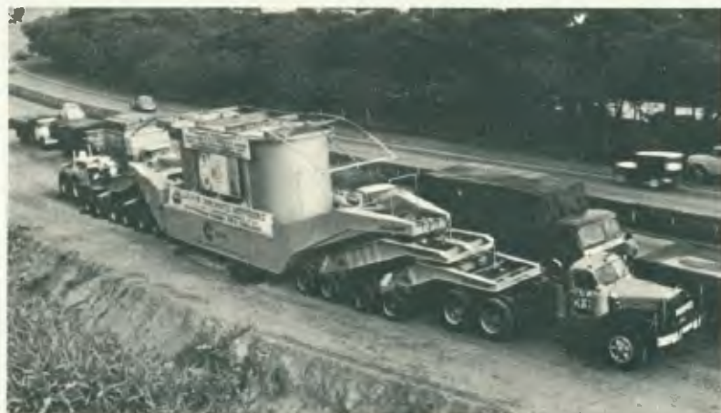
Carrêta de oitenta rodas: levando transformador de 160 t para Cabreúva.
