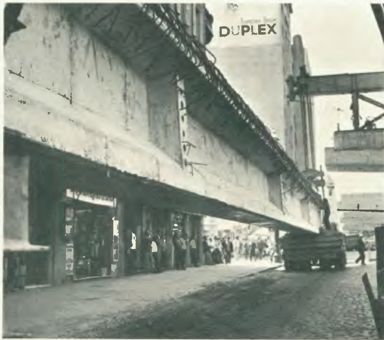
Vigas do "Minhocão": com 40 m e 120 t, exigiram transporte especial.
