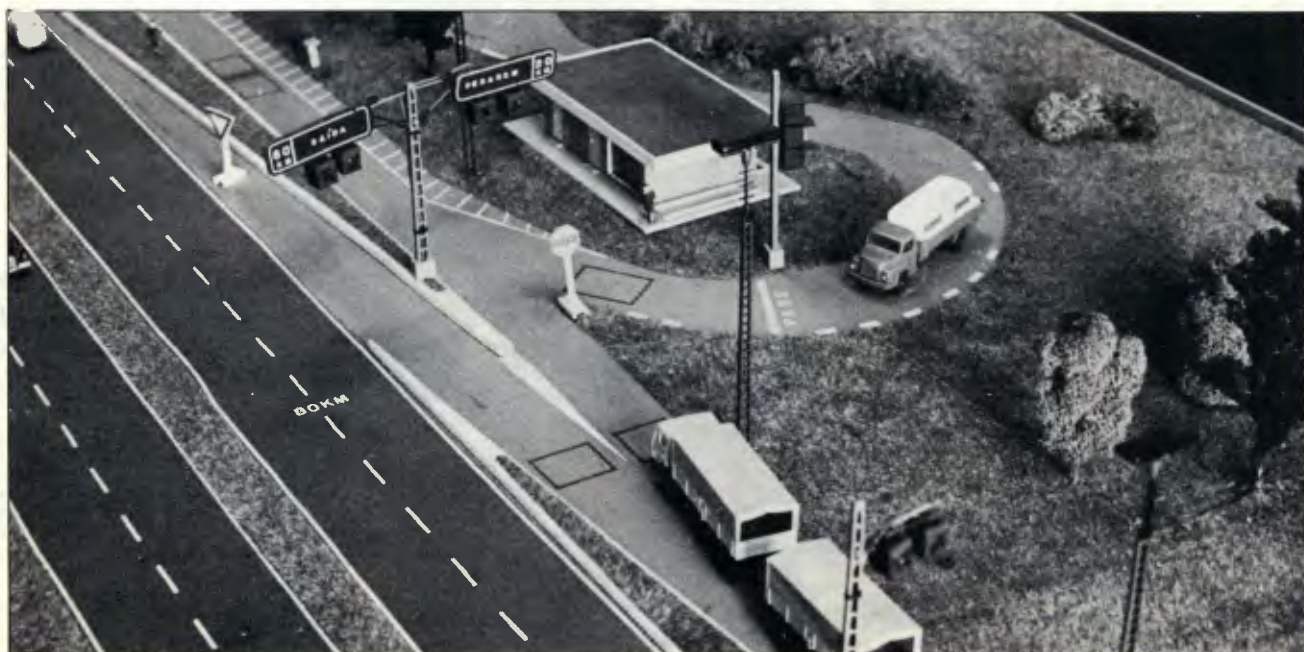
Maquete das novas balanças: os caminhões são pesados a 60 km/h e só reduzem a velocidade se tiverem com excesso de peso.
