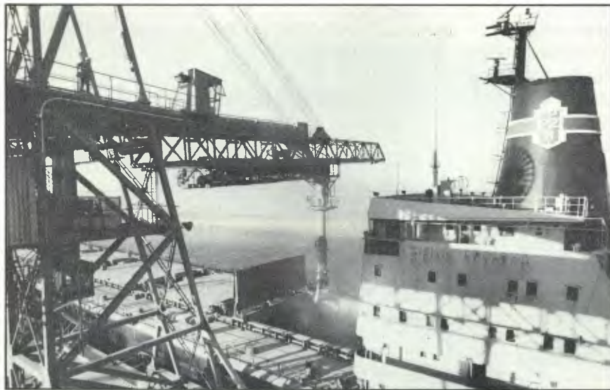
Os pórticos raspadores de armazéns transferem os graneis para esteiras.
