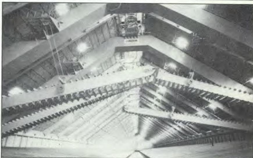
Cada armazém graneleiro tem capacidade para 76 mil toneladas. O cais de recepção de grãos tem três descarregadores pneumáticos.
