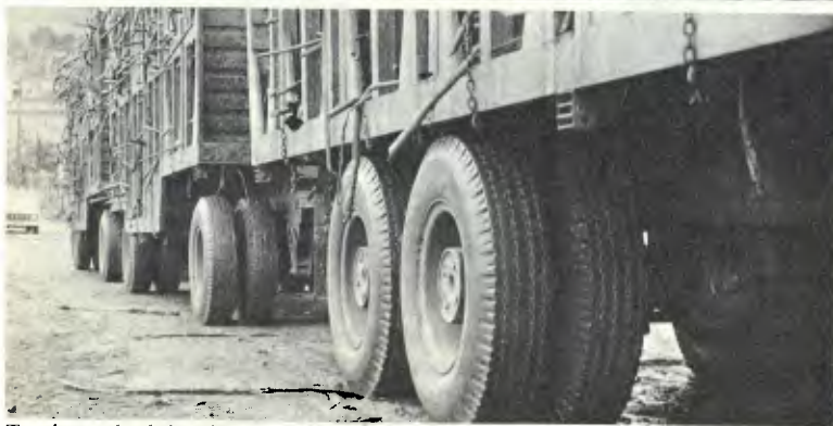
Tracionando dois reboques, o treminhão leva 60 t de carga. O caminhão é carregado separado da Julieta.
