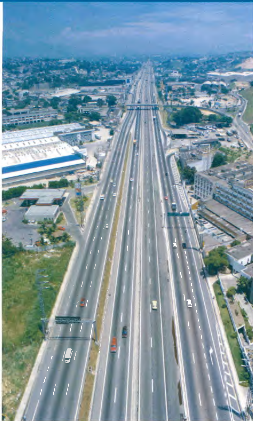
Investimentos pesados em obras garantem as boas condições das estradas operadas por concessionárias
