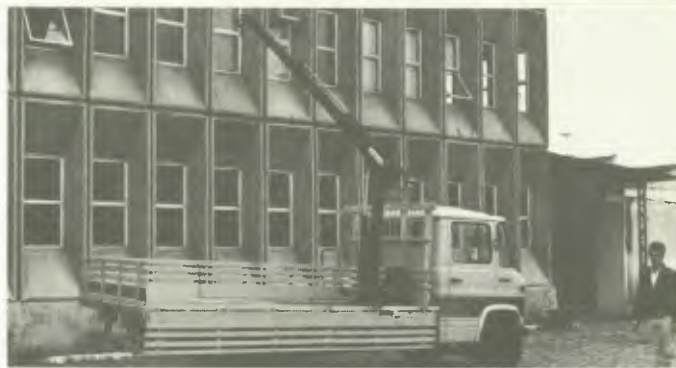
O equipamento foi projetado para caminhão com mais de 4 t
