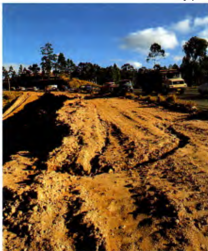
Fernão Dias: obras paradas
