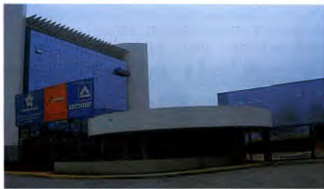
O Centro Integrado de Distribuição em fase final de obras
