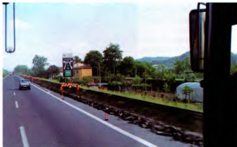
Obras de conservação até no acostamento
