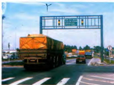
na via, classifica-os por tamanho, determina a velocidade e a transmite para um Controlador Semafórico. Este, por sua vez, determina os tempos dos verdes e vermelhos. A mudança de sinal passa a variar de acordo com o fluxo de veículos, e não mais com tempos fixos predeterminados.
