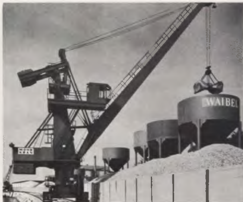
A Bardella vai fabricar guindastes com capacidade de 3 a 15 t e raio de alcance entre 7 e 25 m, usando know-how de uma empresa germânica.
