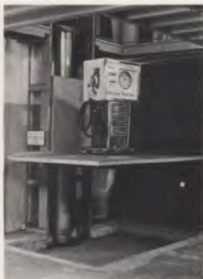
Esta plataforma eleva cargas de até 3 t de um pavimento a outro.
