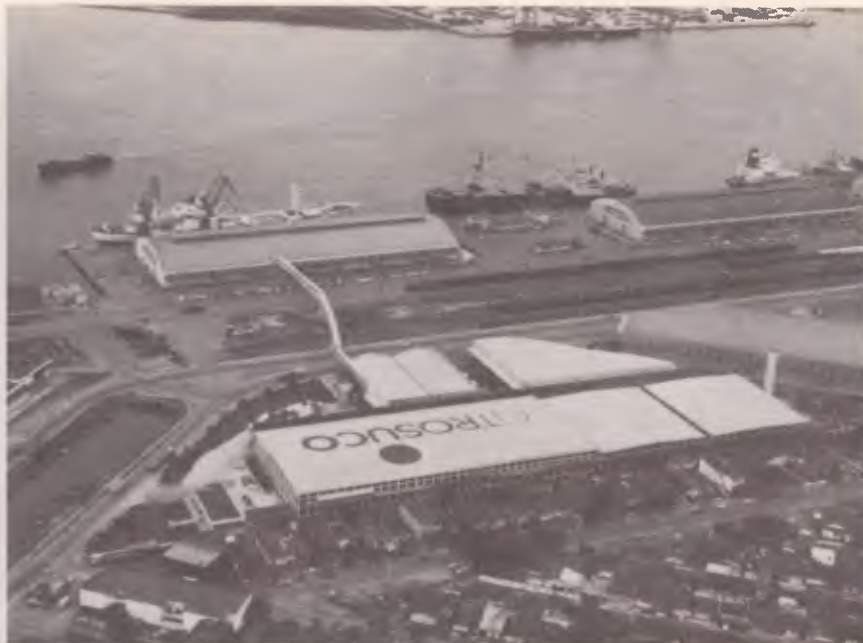
O sucoduto é capaz de carregar um navio de 9 200 t em apenas 36 horas
