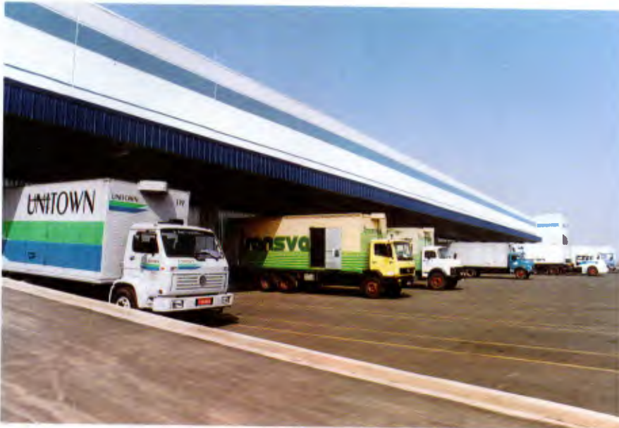
O moderno prédio com 24 docas para caminhões e entradas independentes
