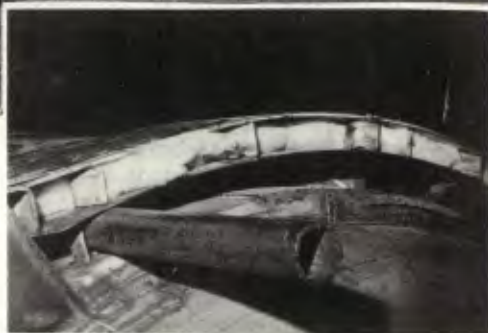
Asfalto exige isolamento térmico
