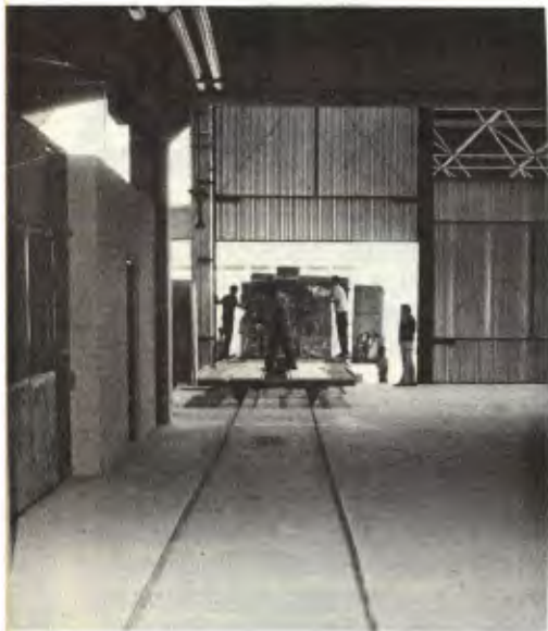
A plataforma hidráulica garante facilidades ao embarque no terminal, provido de trilhos para os racks
