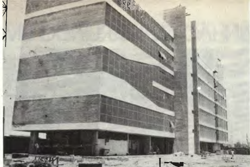
Sede Trensurb: tamanho de um “bonde” para sua capacidade de transporte
