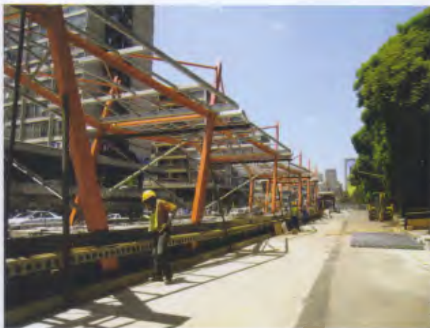
Novo trecho do BRT de Joanesburgo está em adiantada fase de construção
