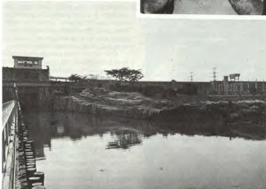
Jamal: no muro-guia, foi utilizado concreto protendido
