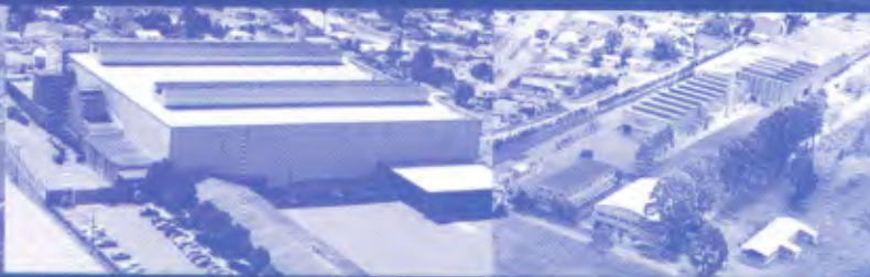
UNIDADE I - FUNDAÇÃO DE FERRO
