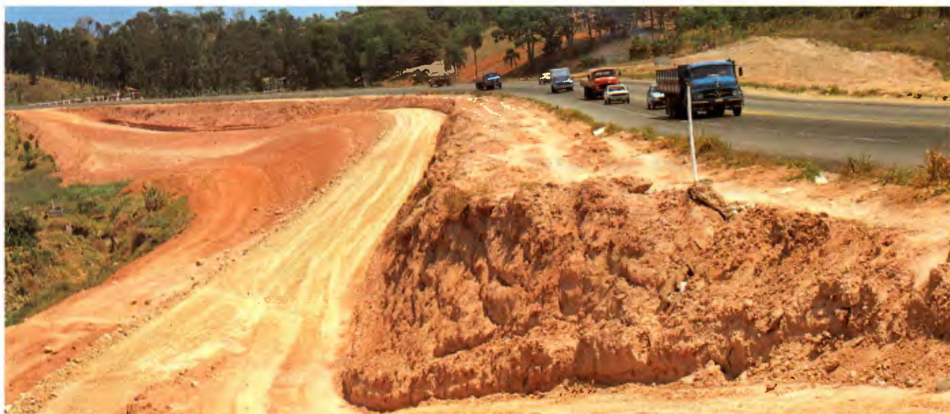
Menos de 20% da obras da Fernão Dias foram concluídas até o final de fevereiro
